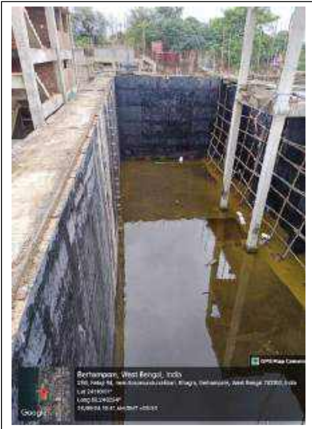
BEHARAMPORE STP SITE
